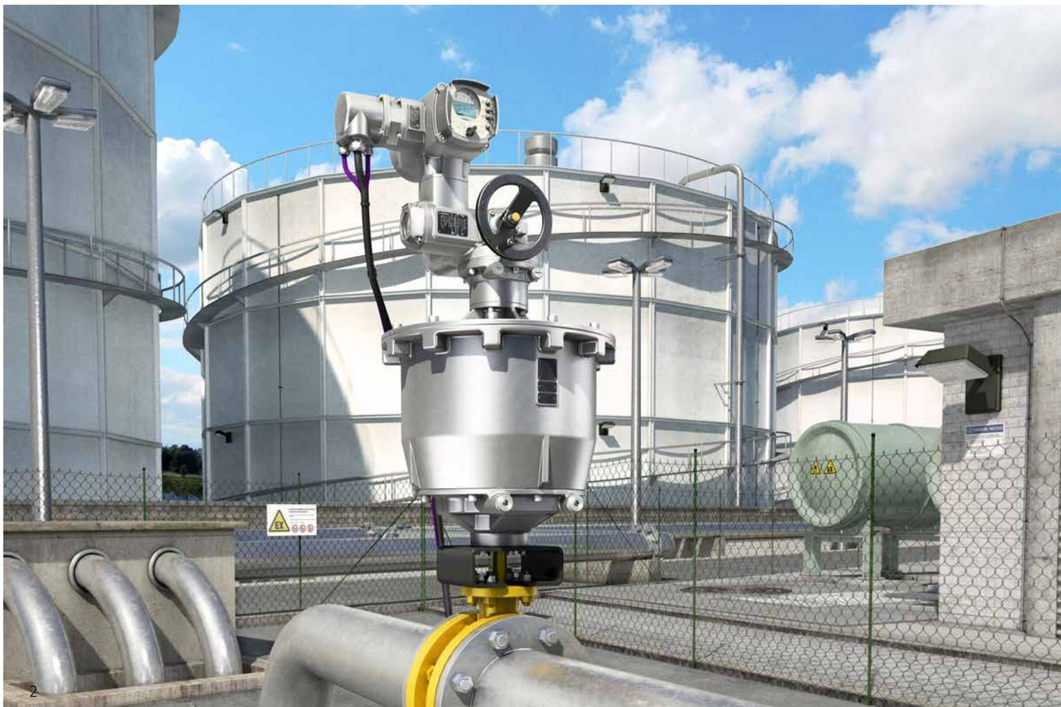
Электроприводы с блоком FQM интегрируются в системы управления аналогично стандартным электроприводам AUMA. Блок отказобезопасности также прекрасно интегрируется в модульные системы AUMA. Он используется в комбинации с неполнооборотными приводами AUMA SQ.
